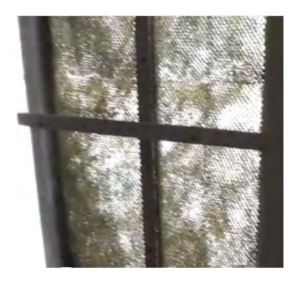
Le pastiglie sono mantenute bagnate da gocce d'acqua pompata alla parte superiore della finestra di una piccola pompa sommergibile sommerso in una scatola di immagazzinaggio di plastica grande riempita d'acqua:
