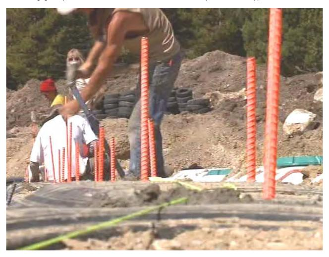
Le barre d'acciaio denominate "tondo per cemento armato" vengono inserite nelle pareti e posizionate all'altezza esatta, e un anello in cemento armato viene gettato intorno alla parte superiore delle pareti per dare forza complessiva alla struttura, prima che i tronchi degli alberi pesanti vengano messi in posizione.
