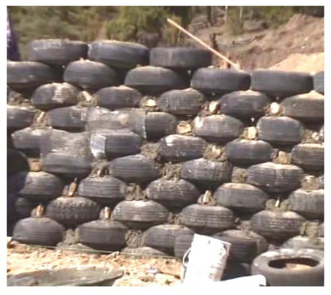
I pneumatici sono sovrapposti in file successive, formando una struttura stabile e quindi viene applicata la stuccatura tra di loro. L'esterno è racchiuso in una banca di terra e l'interno è successivamente levigato.
