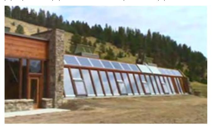
Le pareti della proprietà sono spesse sette piedi (2,13 metri) per consentire l'uso di materiali abbastanza semplici e, cosa più importante, per fornire una massa termica che mantiene l'interno dell'edificio caldo
